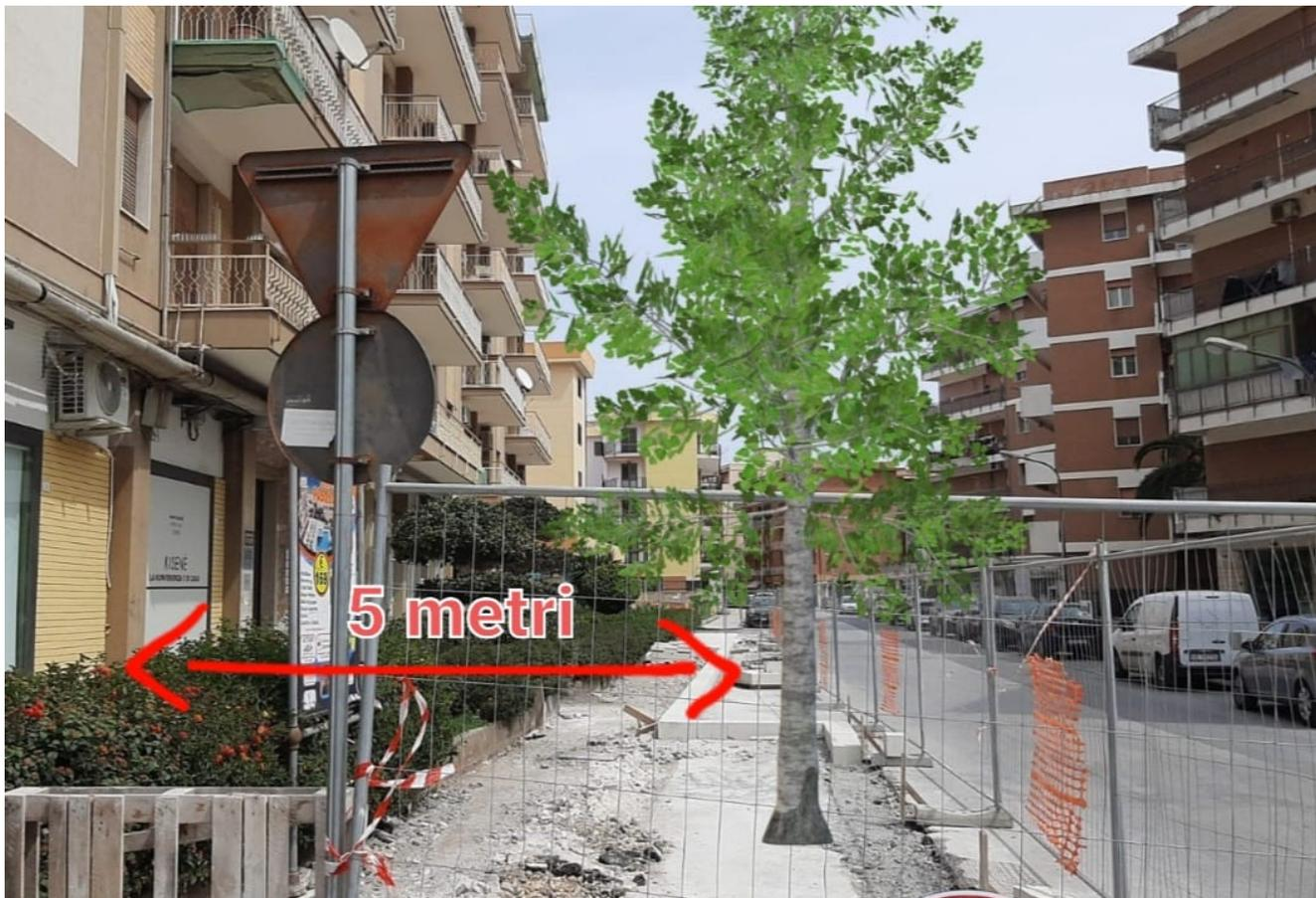
L'impianto delle "alberature da ombra del tipo caducifoglie" riguarderà entrambi i lati della strada e viene eseguito senza modifiche all'impianto strutturale originario. Questo perchè le nuove piante (i platani) verrebbero inserite in formelle quadrate con il lato di 2 metri, poste a 5 metri dai prospetti dei palazzi così da impedire l'interferenza delle chiome con gli edifici e garantire, al contempo, il corretto e completo sviluppo degli alberi.
